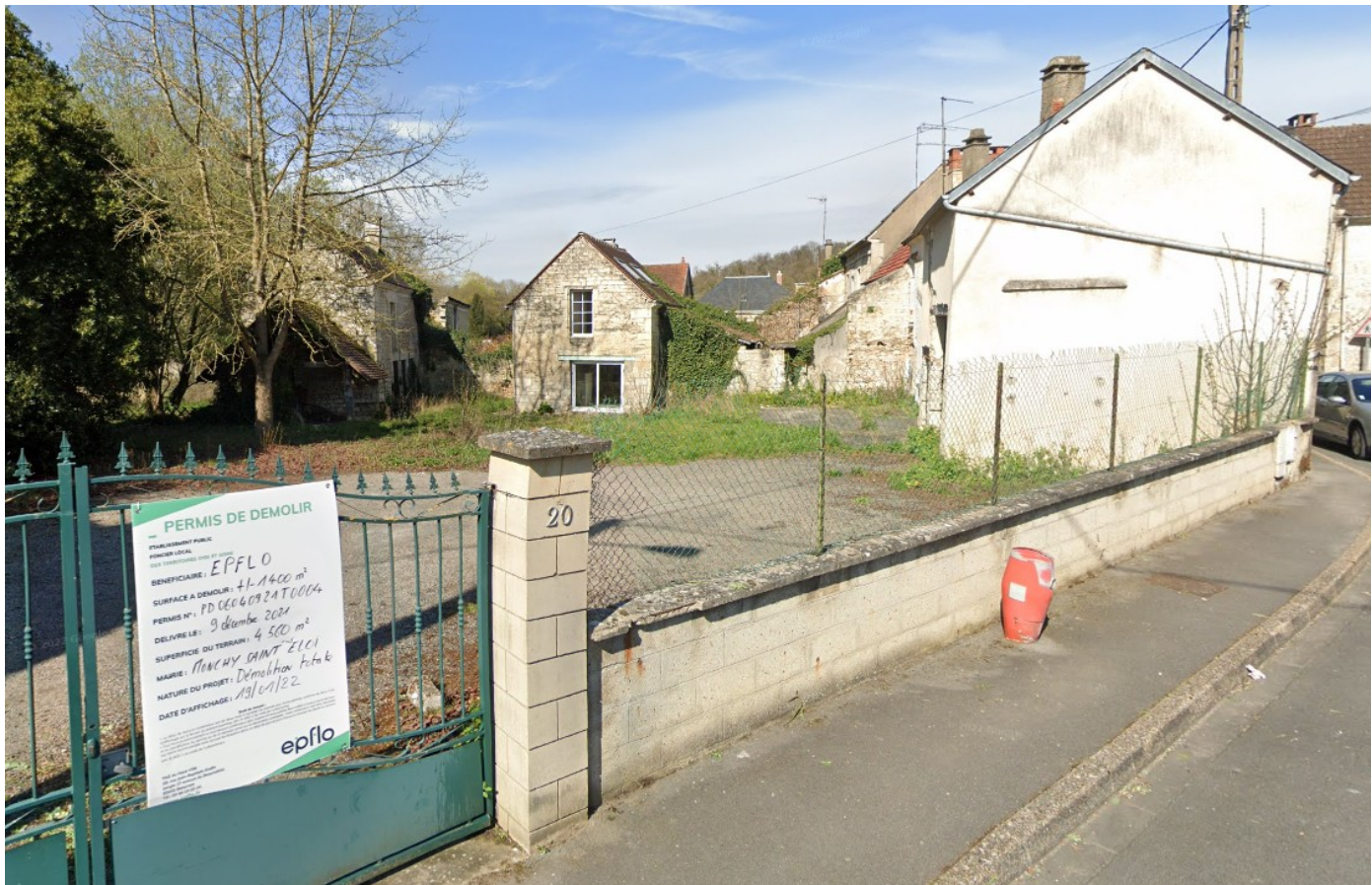
Anciennes bâtisses vétustes à démolir à Monchy-Saint-Eloi
